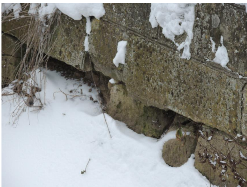
Poruchy na zdivu, uvolněné kameny, vydrolená a vypadaná zdící malta stykových spár
