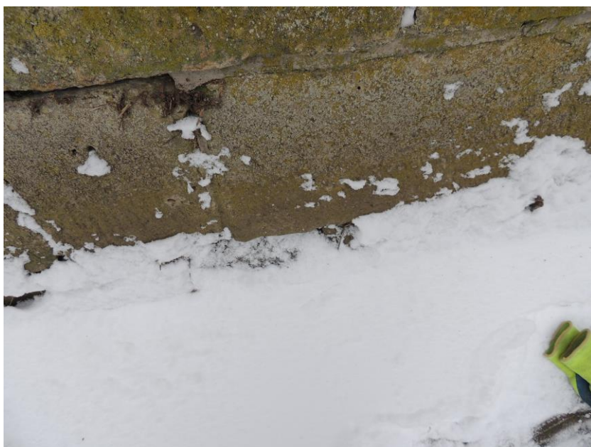
Popraskané a vypadané stykové spáry zdiva nábrežní zdi
