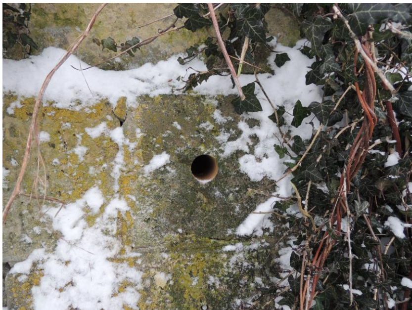
Místo odběru vzorku pro stanovení pevnosti kamene
