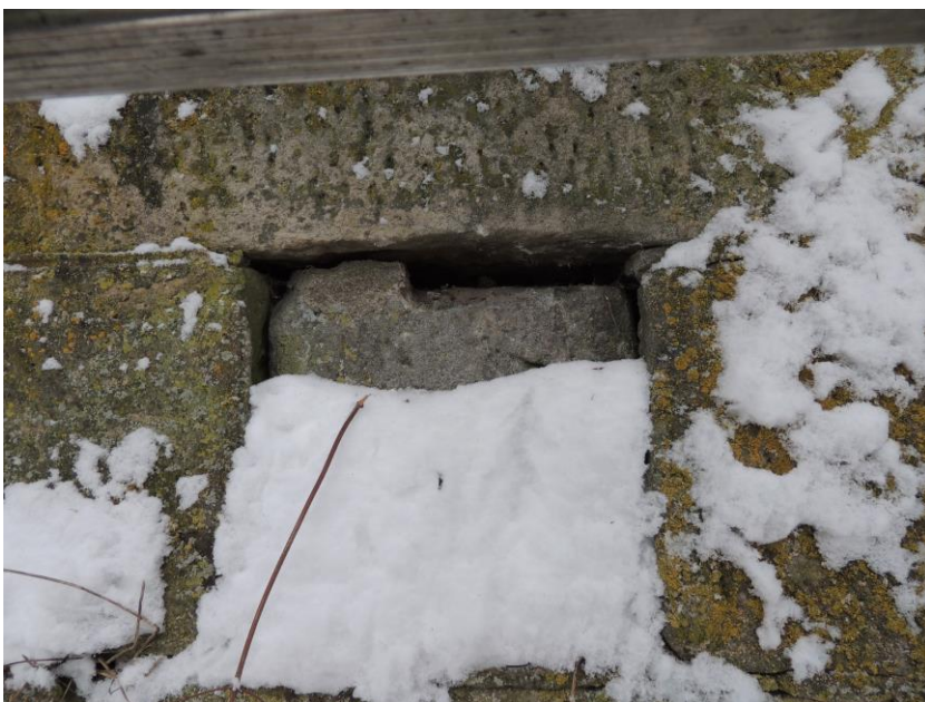
Zcela uvolněný kámen ve zdivu nábrežní zdi
