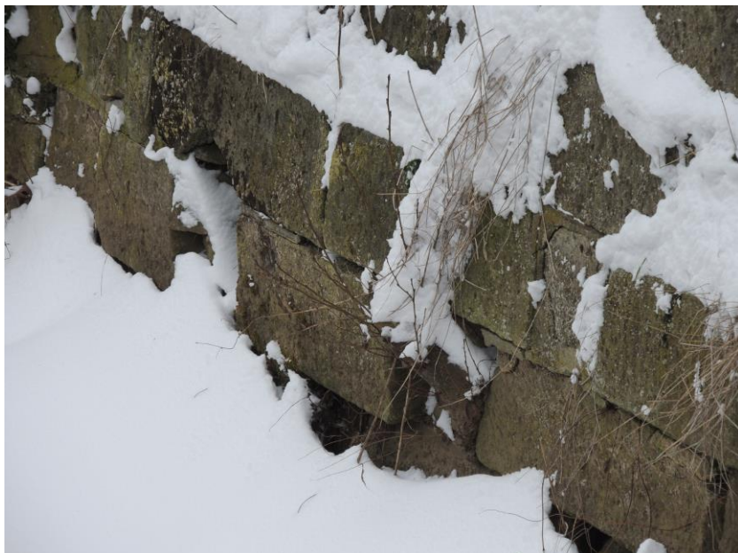
Poruchy na zdivu, uvolněné kameny, vydrolená a vypadaná zdící malta stykových spár
