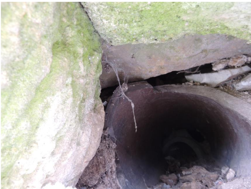
Vývod potrubí skrz nábrežní zeď, viditelná tloušťka zdi
