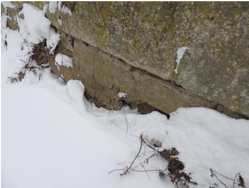
Popraskané, vypadané stykové spáry a uvolněné kameny zdiva nábrežní zdi
