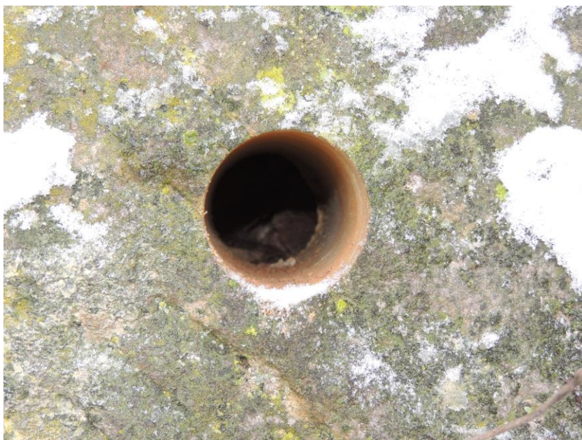
Pohled do otvoru po odběru vzorku, viditelná tloušťka zdiva
